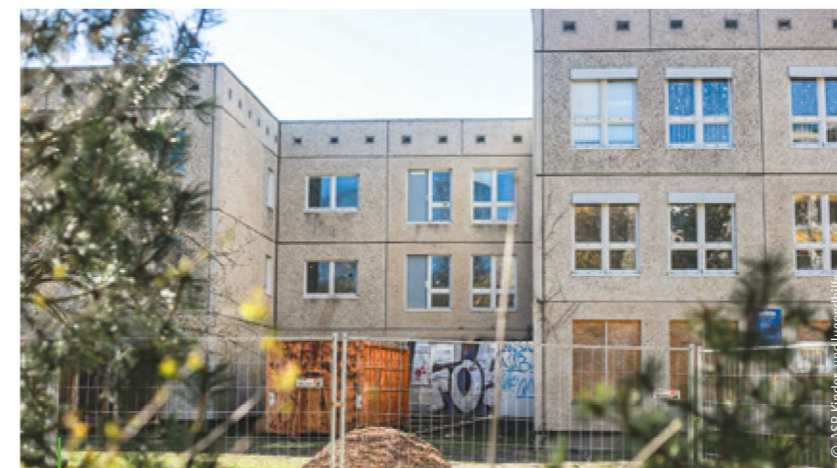
Bau aus den 1980er-Jahren vor der Sanierung
